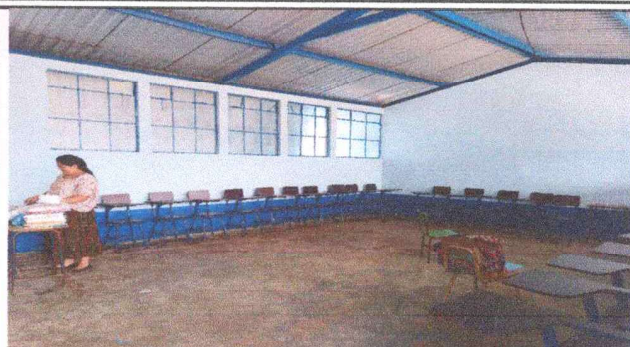
Foto 2. Trabajos de mantenimiento y pintura de estructura portante en modulo 2.
