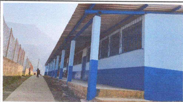
Foto 1. Se tiene ya terminado el mantenimiento de la escuela y la pintura del modulo ya se encuentra finalizada totalmente en esta area del modulo 2.
