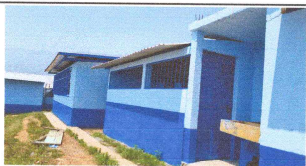
Foto 5: Cernido y repellido ya finalizados, se observan las paredes del modulo de baño de niñas ya pintadas en su totalidad.
